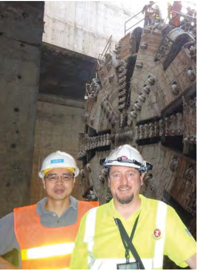
施宏楚（左）与港铁公司团队在高铁香港段隧道施工期间进行检查
