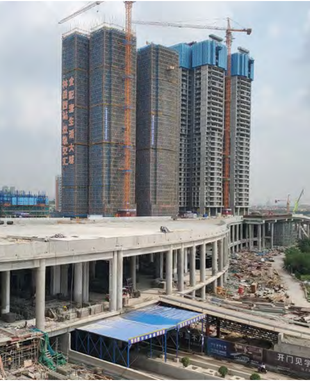
林岳西站TOD在建项目
