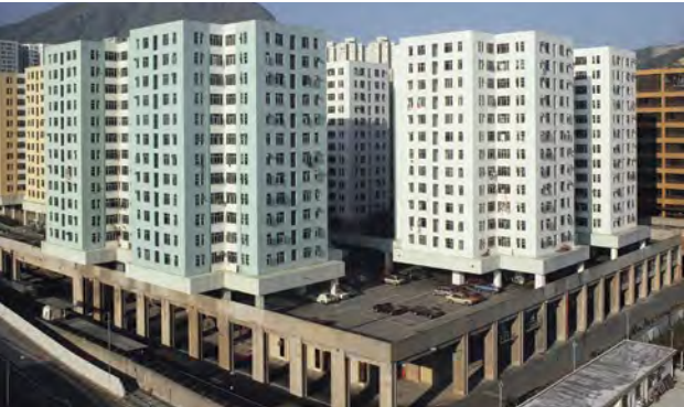
德福花园发展项目，建于九龙湾铁路站车厂上盖。
