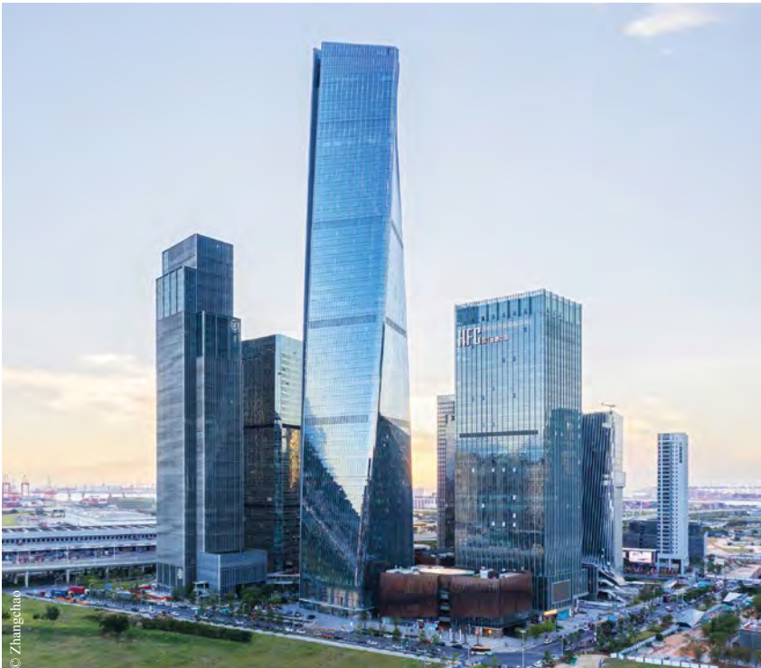
前海世茂中心是中国最高的外框结构扭转建筑。由马晖领导的团队开创性地设计了扭转框架—核心筒结构体系，使该建筑具有独特的螺旋形态。
